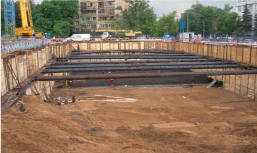
Рисунок 3 – Огородження котловану зі сталевих елементів із забіркою
