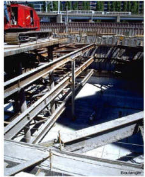
Рисунок 12 – Розпірне кріплення котлованів за допомогою горизонтальних (а) і вертикальних (б) ферм
