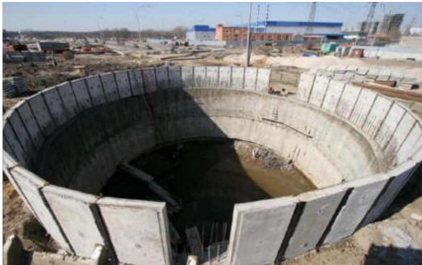
Рисунок 2 – Занурення збірно-монолітного опускного колодязя
