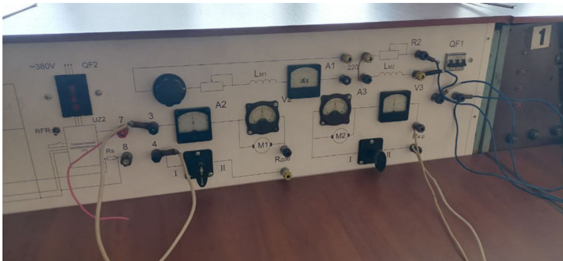
Рисунок 2 - Загальний вигляд стенду лабораторної роботи №1
