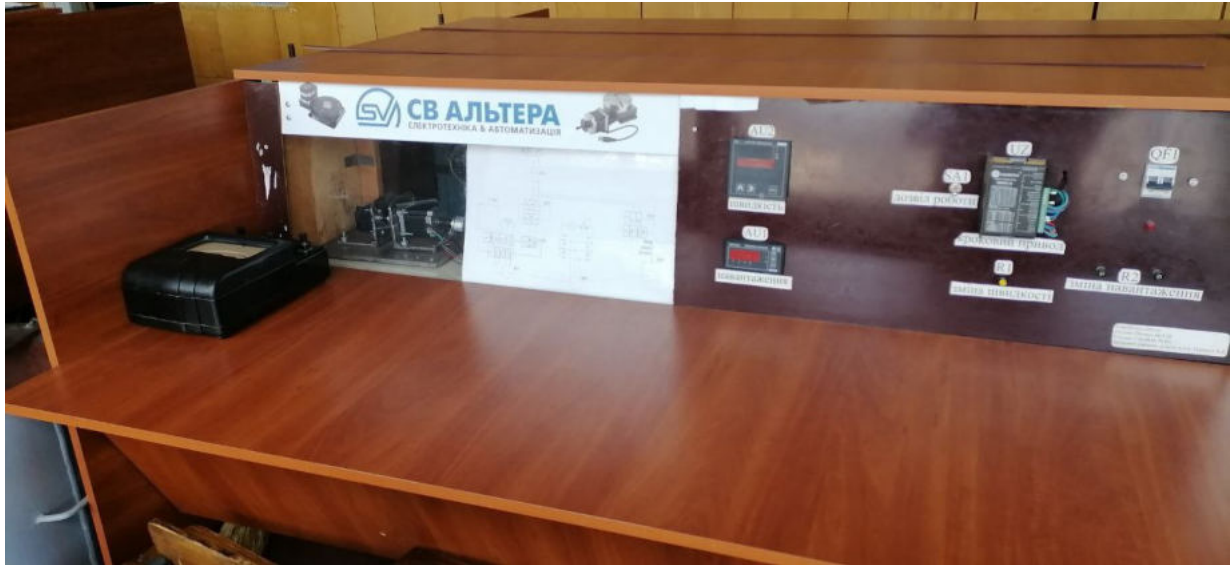
Рисунок 10 - Загальний вигляд стенду лабораторної роботи №9
